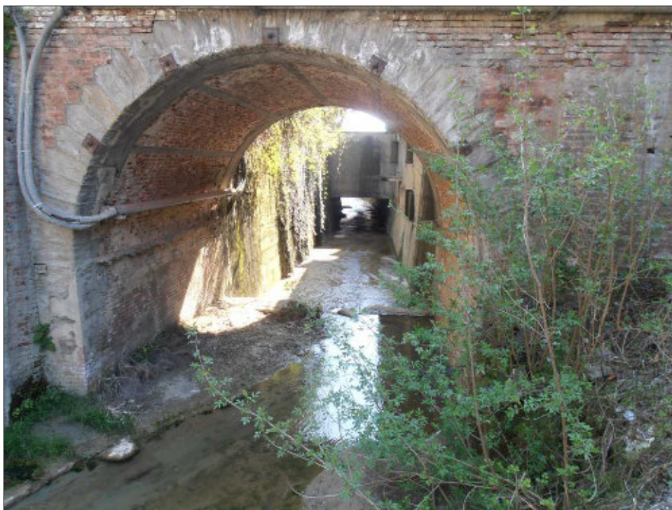
Figura 10: L'attraversamento sulla Via Alessandria – vista da monte verso valle
