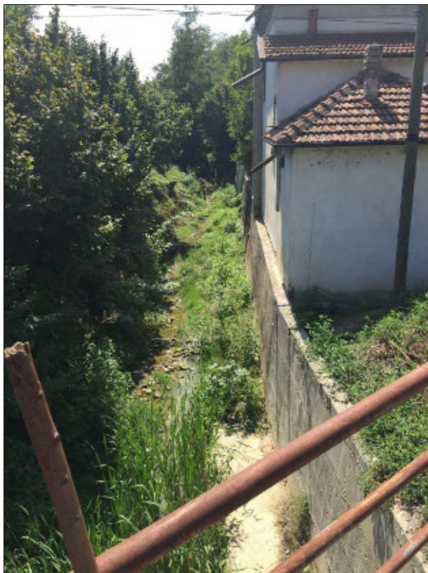
Figura 13: Il muro in sinistra a protezione degli edifici esistenti a monte dell'attraversamento
