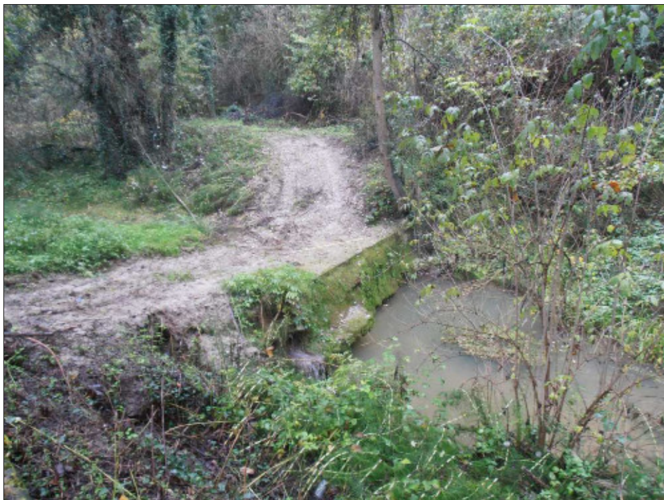
Figura 7: Manufatto n. 3 – Vista dalla sponda destra verso monte
