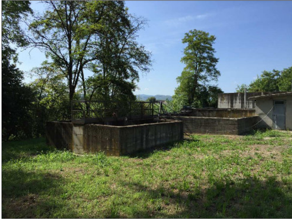
Figura 14: Il depuratore comunale sito in sommità alla sponda sinistra
