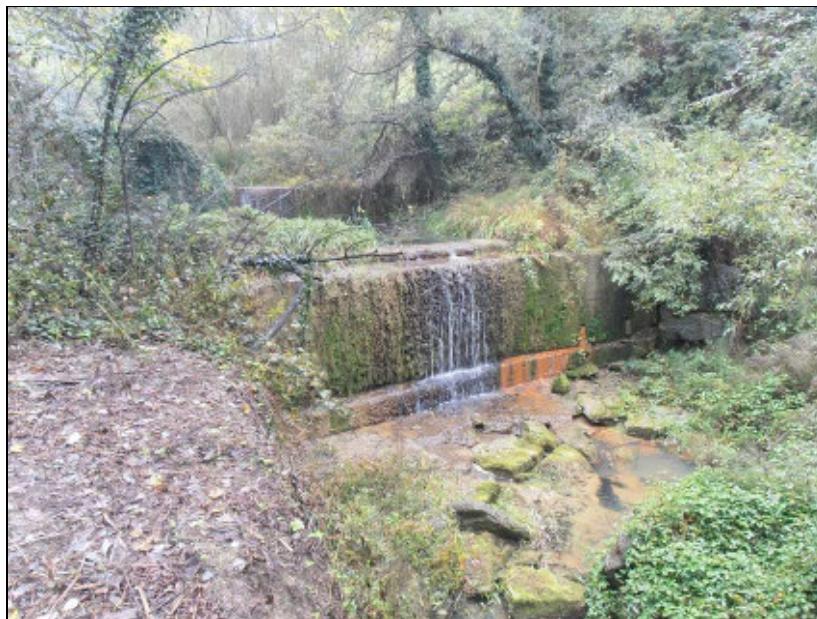
Figura 4: Manufatto n. 1 - Briglia e controbriglia sul Rio Crosio – Vista dalla sponda destra verso monte
