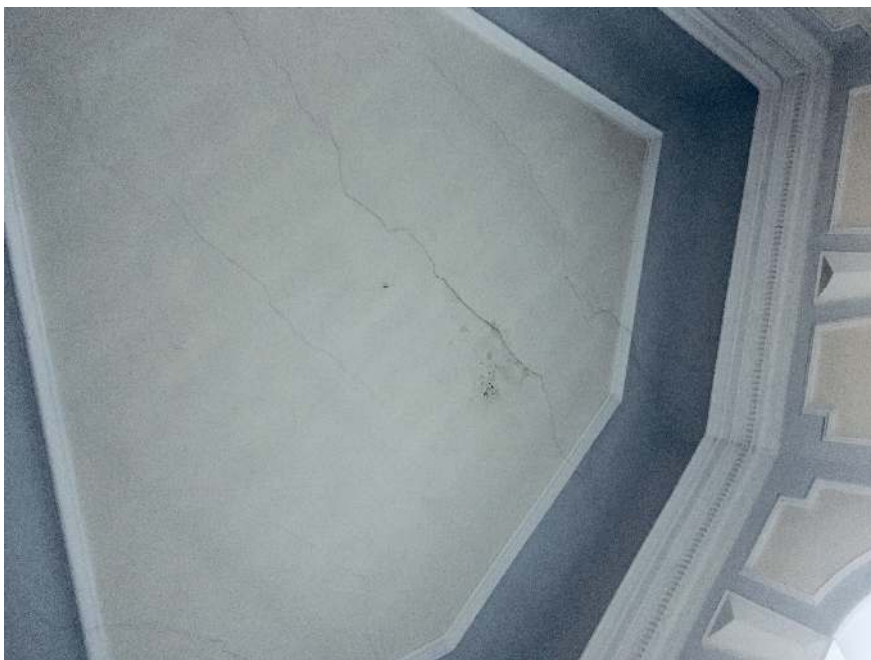
Solaio copertura scalone principale
