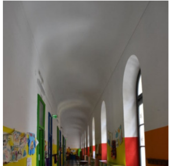
Corridoio P1 lato via Ottolenghi
