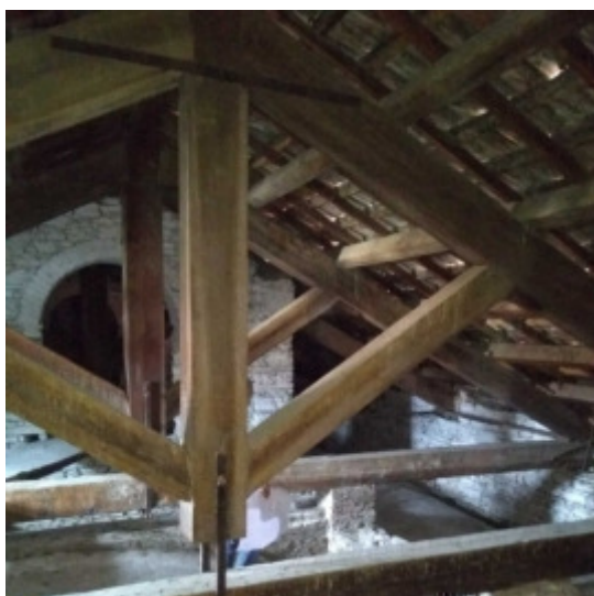
Sottotetto edificio principale
