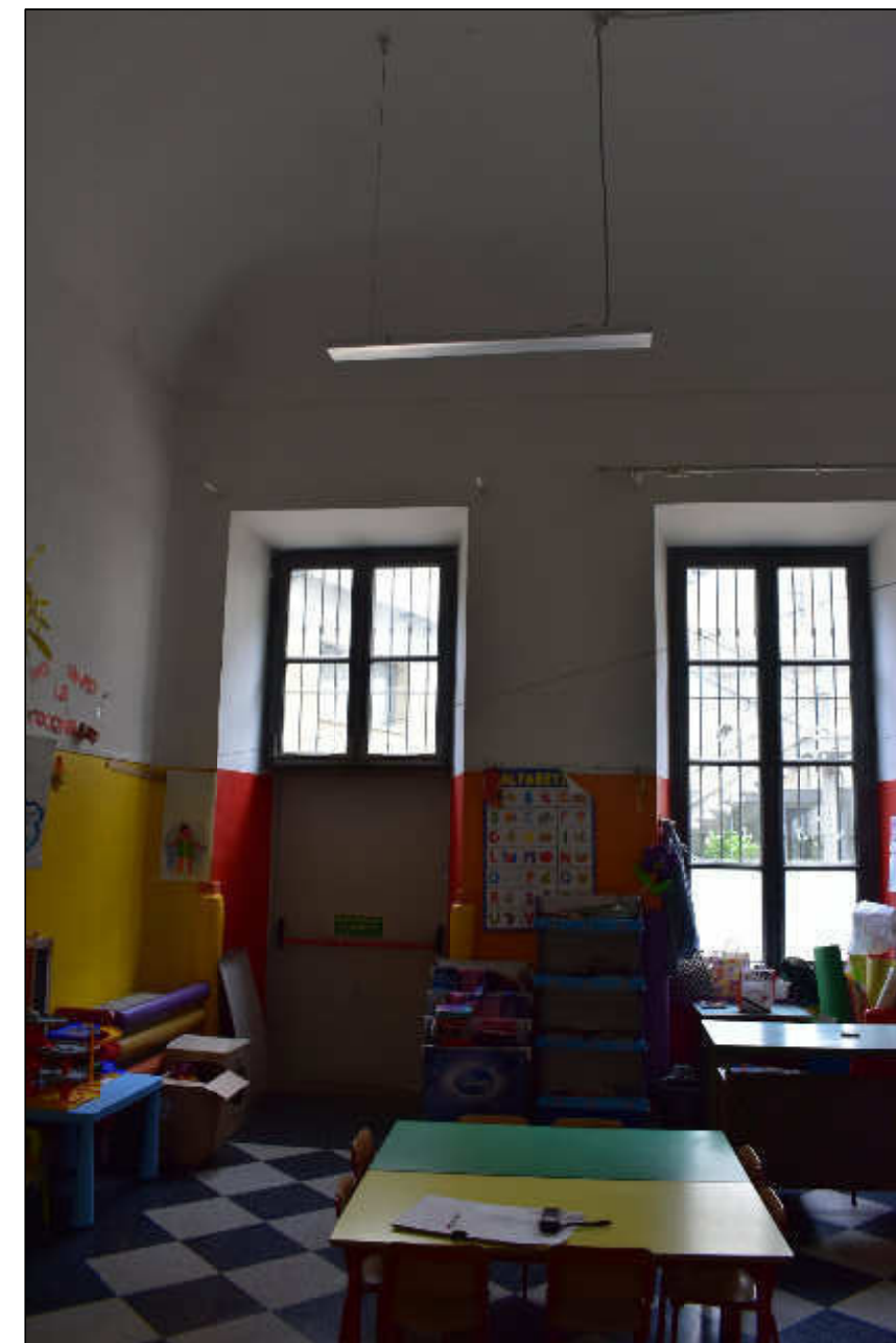
FOTO N°2 (aula PT ala Ottolenghi)
