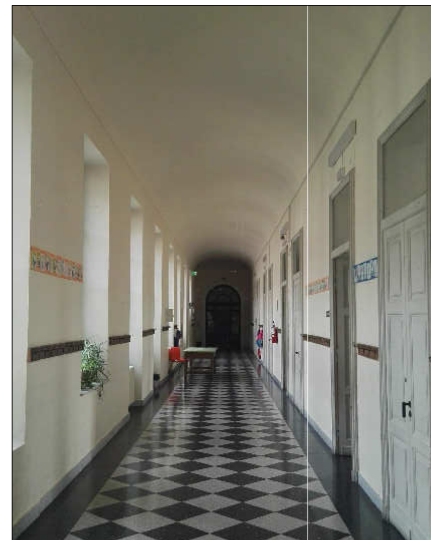
FOTO N°2 (corridoio P2 ala XX Settembre)
