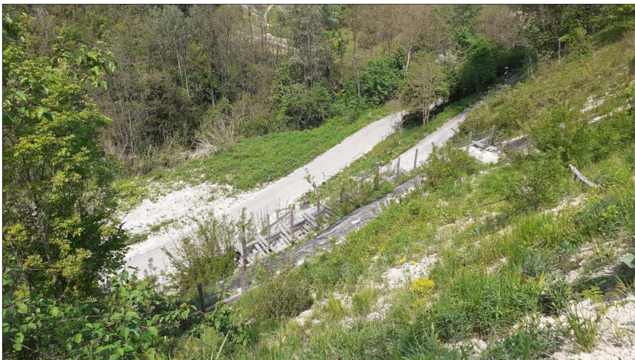
Vista dal settore mediano della scarpata della strada comunale regione Lacia e della barriera esistente
