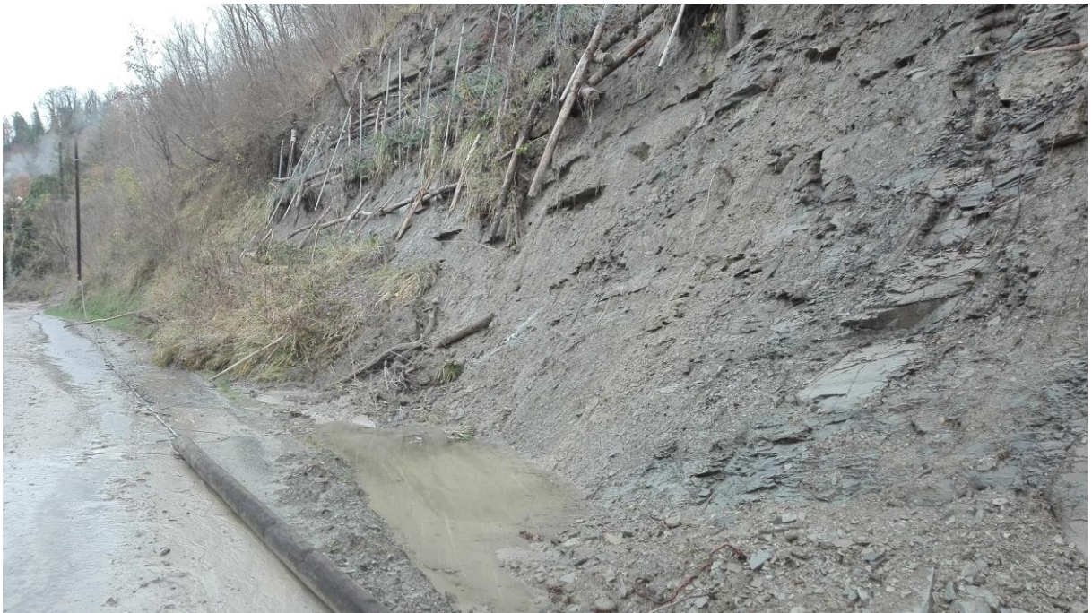
FOTO 3-4 TRATTO SCARPATA RELATIVO INTERVENTO 3
