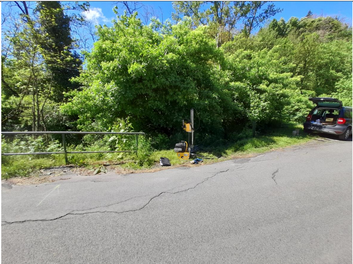
Foto 1 – esecuzione prova P1
