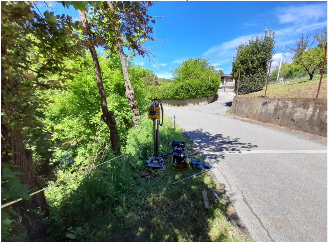
Foto 2 – esecuzione prova P2
