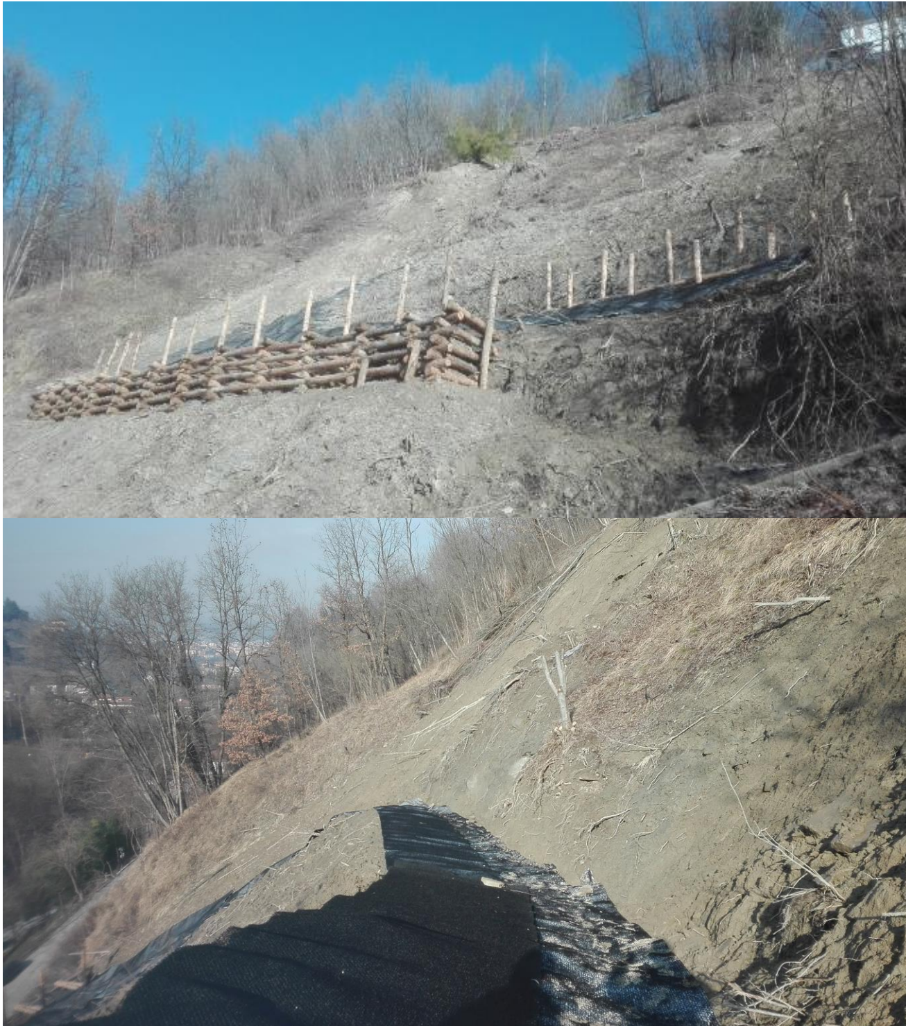
Foto 1-2 interventi provvisori eseguiti in regime di somma urgenza
